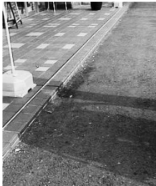
図1 段差をなくした道路
