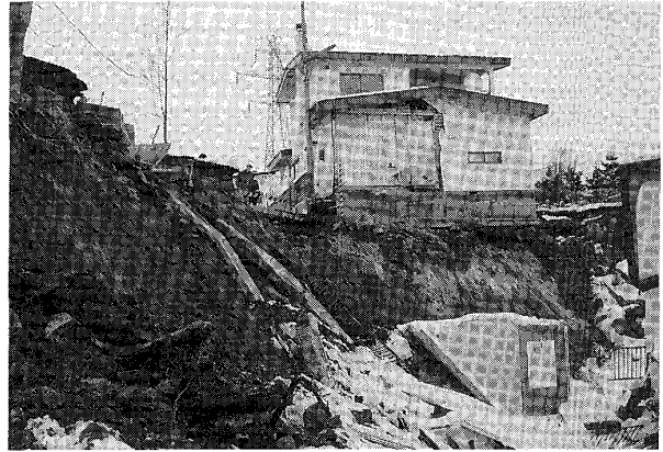
1993年釧路沖地震による丘陵造成地の被害
