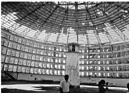
図6 ハリケーンで屋根が崩落した様子
