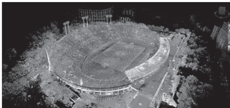
図6 旧国立競技場 外観計測データ 千駄谷門上空の視点より
