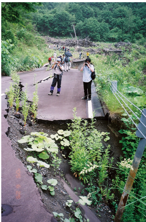
写真2 道道平取・えりも線の崩壊地
