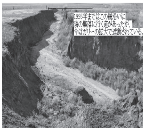
写真2 浸食により拡大するガリー
